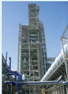
MIDREX®プラント (オマーン)
