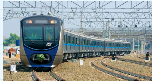
ジャカルタ都市高速鉄道南北線
