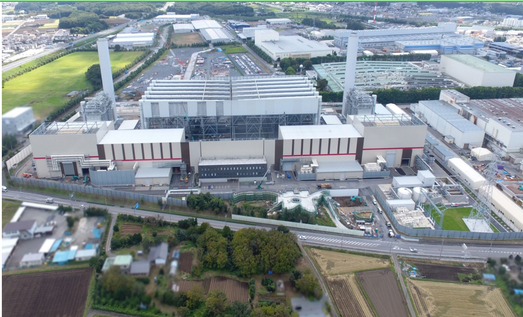
真岡発電所の写真 (2019年9月撮影)
