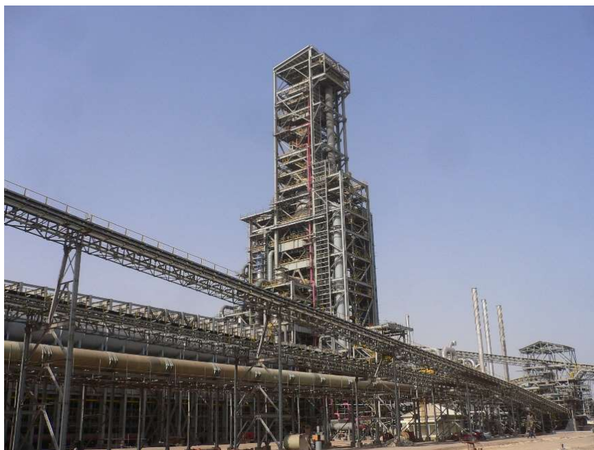
Qatar Steel No.2 プラント (カタール) (150万t/年)
