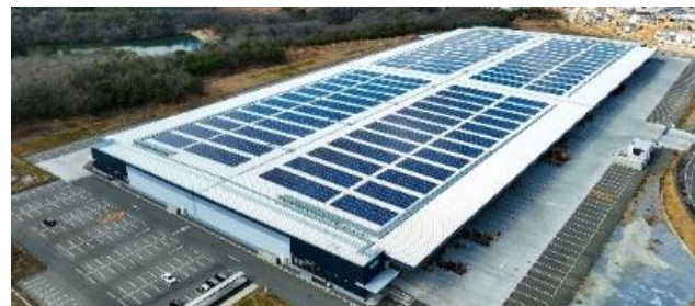
東条パーツロジセンター(約20,000㎡)
