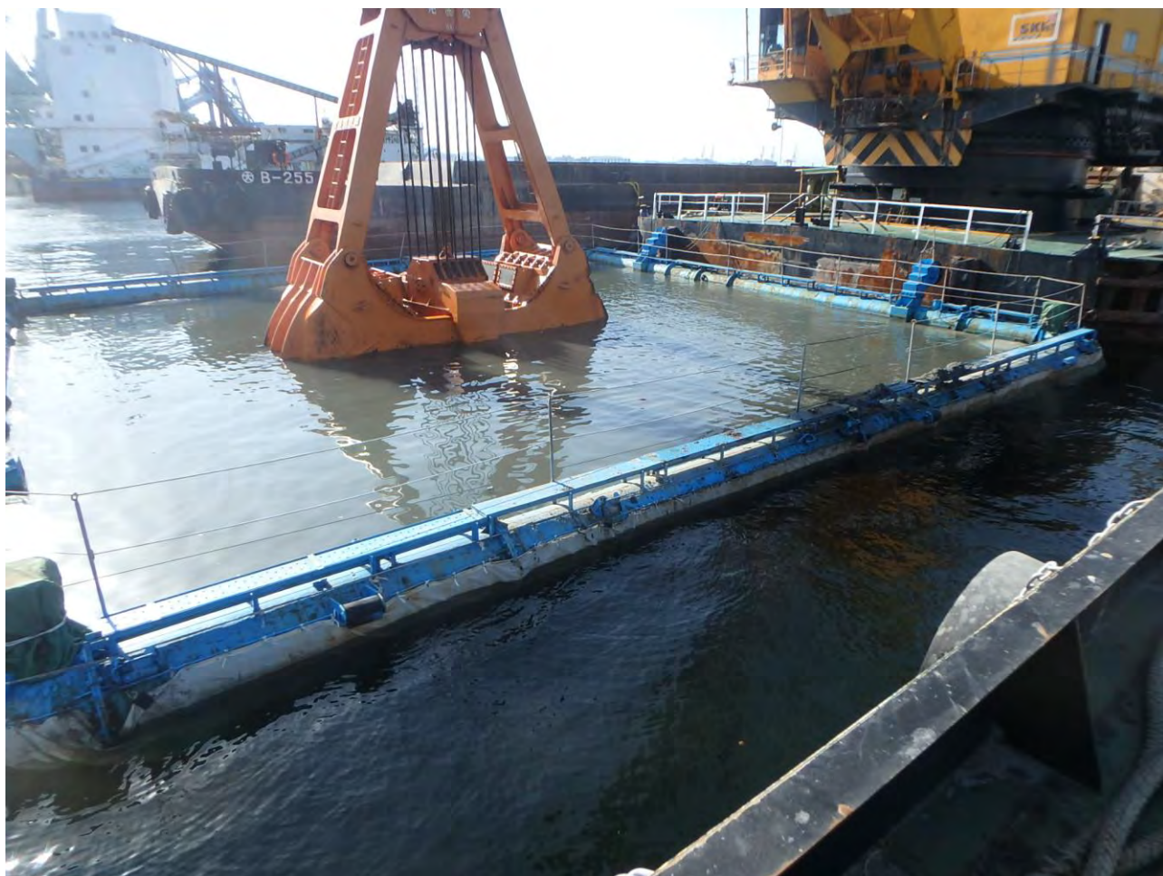
写真 4.4-2 汚濁防止膜の設置状況
