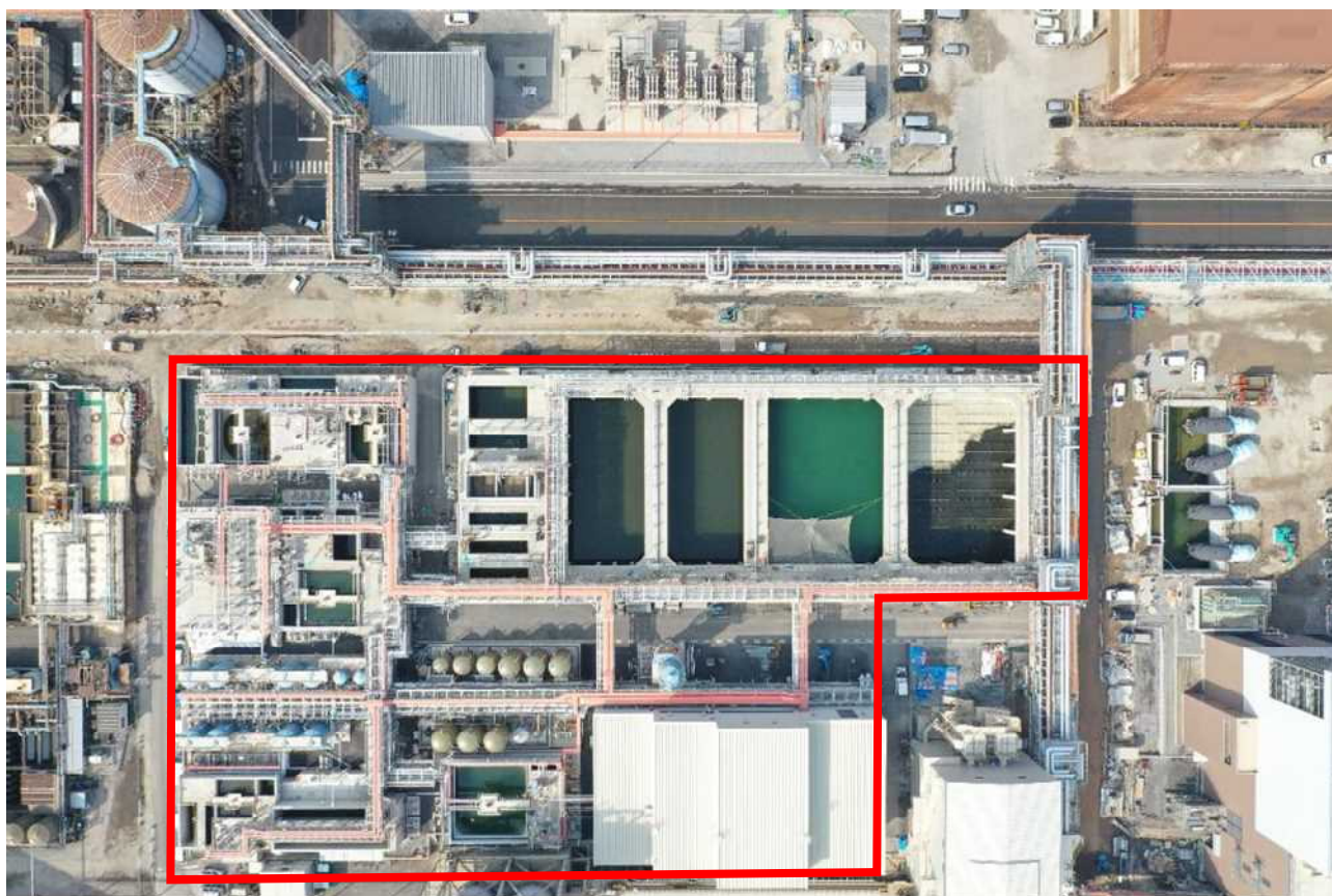
写真 4.4-2 総合排水処理設備（新設）の設置状況
