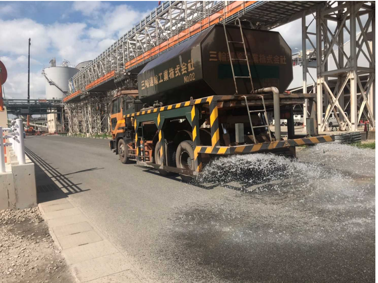
写真 4. 1-1 令和 2 年度における車両洗淨及び道路散水の実施状況
