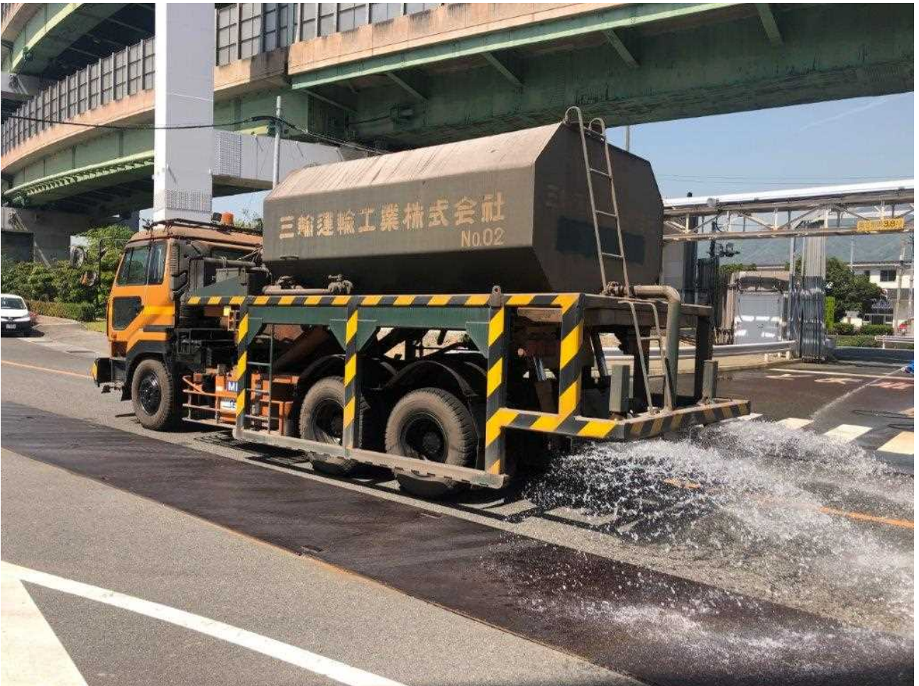
写真 4.1-1 令和3年度における車両洗淨及び道路散水の実施状況
