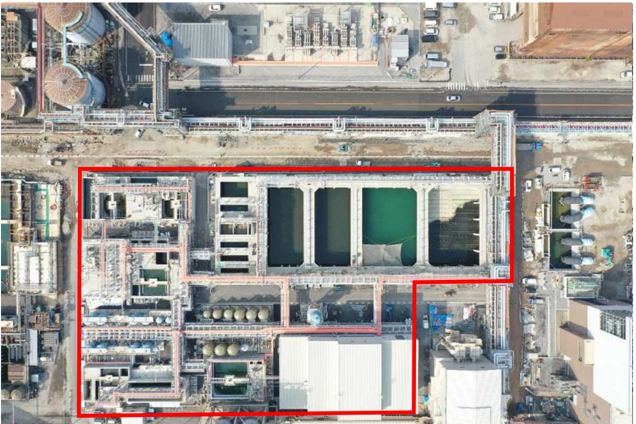
写真 4.2-2 総合排水処理設備（新設）の設置状況
