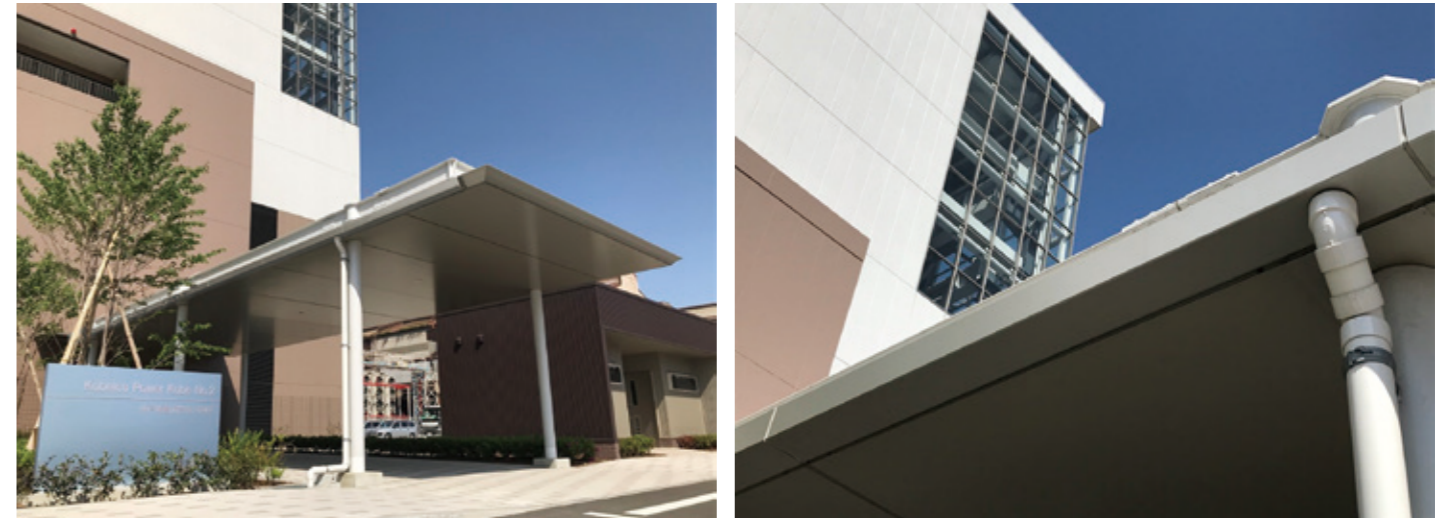
■神戸製鋼所神戸発電所(兵庫県)・・・雨樋
