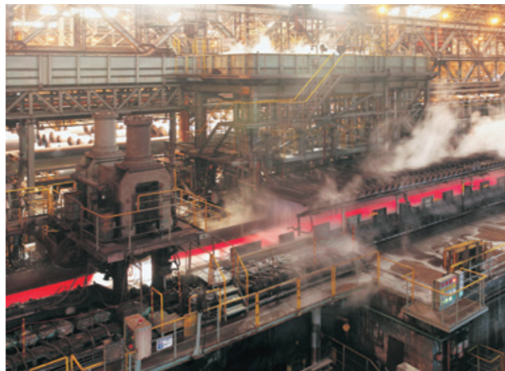
制御冷却装置
