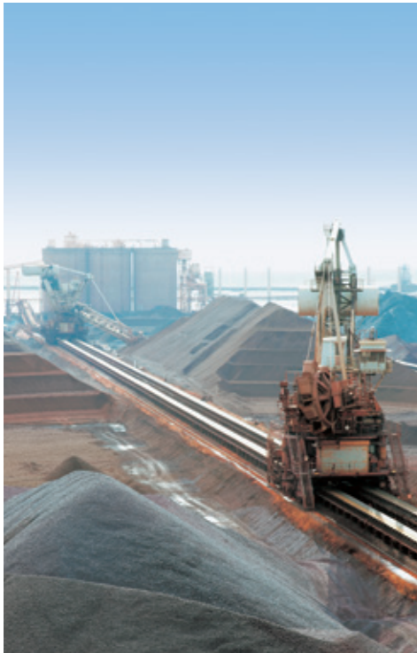
原料ヤードのスタッカ、リクレーマー
