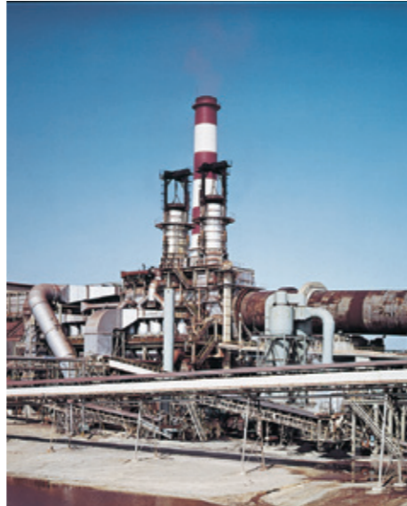
ペレット製造設備
