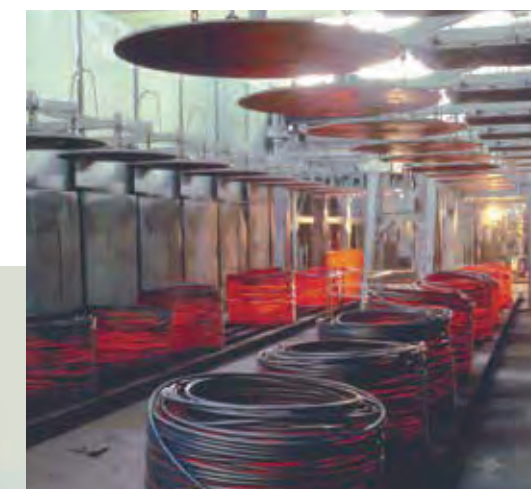
▲線材搬送設備
