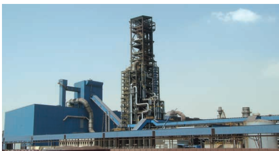
図10 HADEED Module-E プラント Fig.10 HADEED Module-E plant
