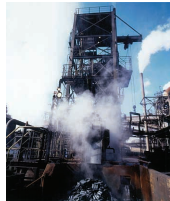
図10 加古川 HBI デモプラントにおける塊成化テスト Fig. 10 Agglomerate test in Kakogawa HBI pilot plant
