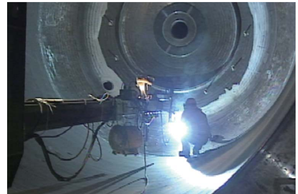
压力容器内壁堆焊照片
