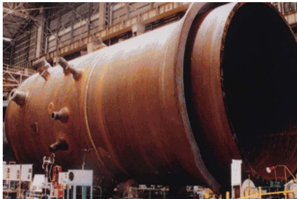
现场施工照片 <反应堆压力容器(RPV)>
