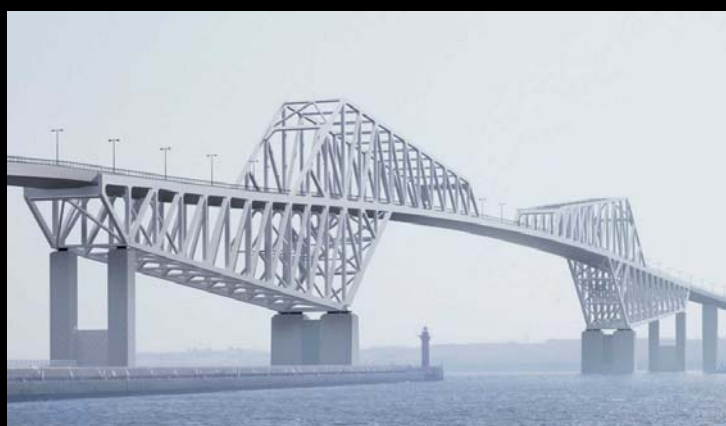
BHS500 鋼板を採用した東京湾臨海大橋(仮称)の完成予想図
