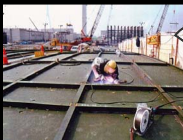
PREMARC DW-N70S を用いた半自動溶接
