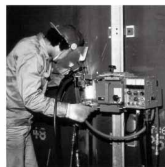
EGW法立向焊接
