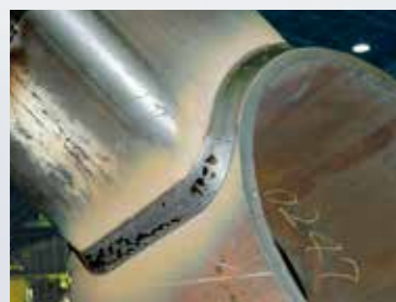
溶接ビード外観
