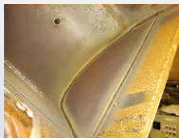
溶接ビード外観
