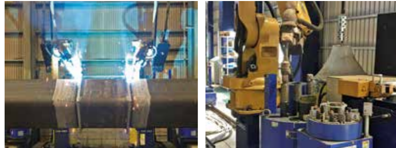
2アーク溶接の様子 ノズル清掃・交換も2台同時に実施
